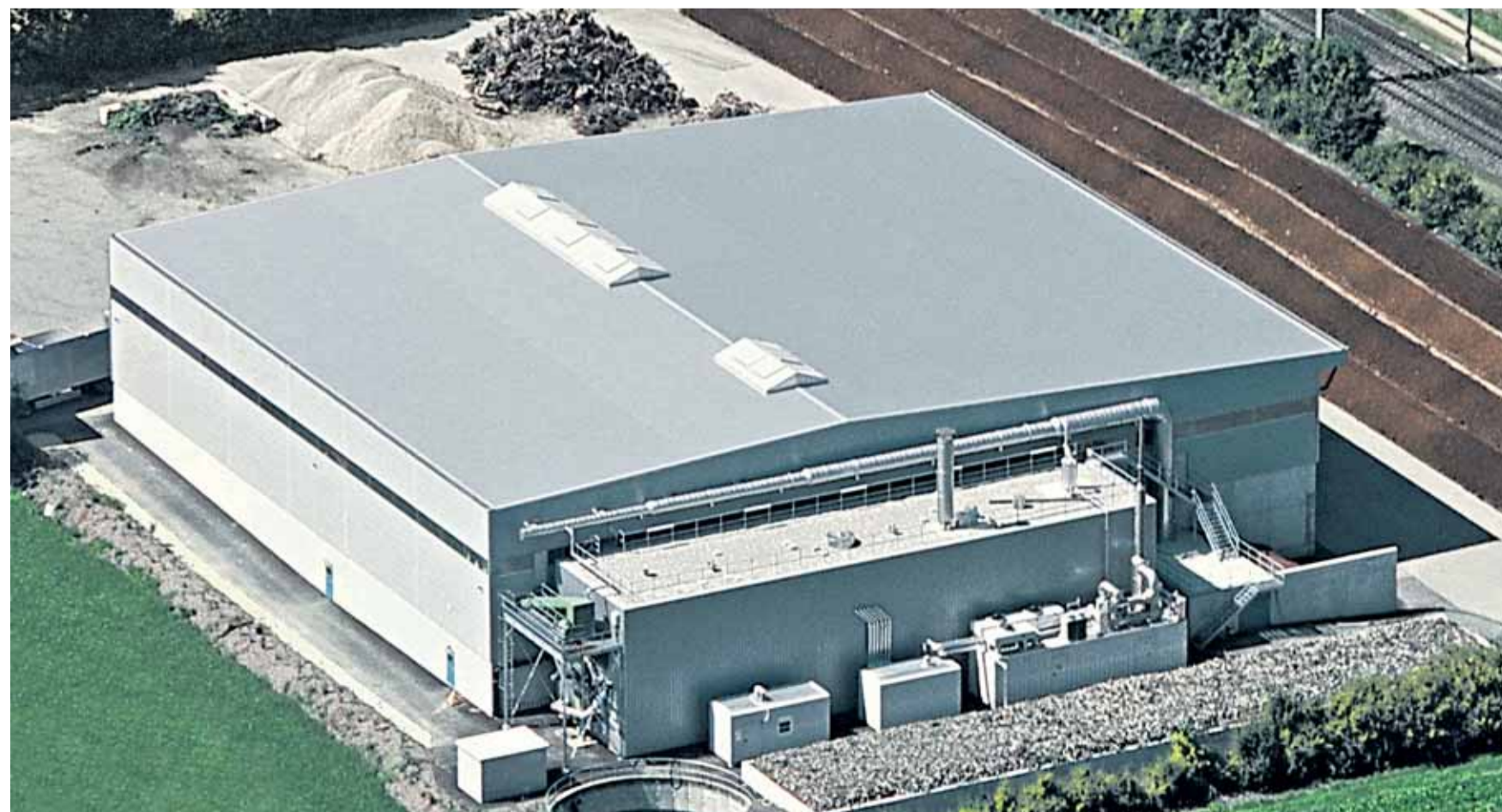
L'installation Kompogas d'Oensingen (SO) est l'un des 14 sites en Suisse où les biodéchets des communes et des entreprises sont transformés en énergie au bilan CO 2 neutre et en engrais naturels de valeur. (Photo: Axpo Kompogas AG)
