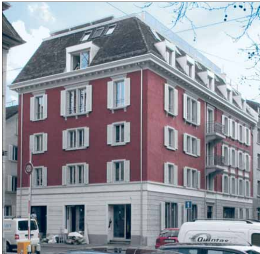
Il aura fallu six mois à peine pour assainir intégralement l'immeuble collectif de la Magnusstrasse 28 à Zurich – avec aménagement d'un nouvel étage sous le toit à partir d'éléments préfabriqués.
