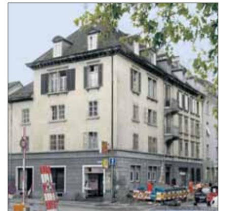
Il aura fallu six mois à peine pour assainir intégralement l'immeuble collectif de la Magnusstrasse 28 à Zurich – avec aménagement d'un nouvel étage sous le toit à partir d'éléments préfabriqués.
