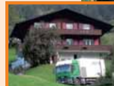
Confortation et relevage d'une maison de 55 cm
