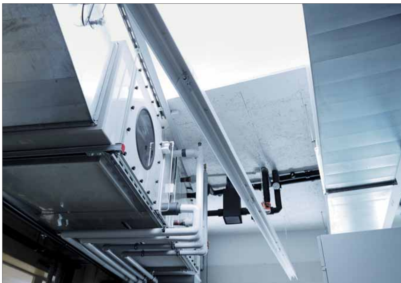
Verantwortlich für das Wohlbefinden im Drucksaal ist der eigens für die Jost Druck AG gebaute Monoblock. (Fotos: Regula Roost)
