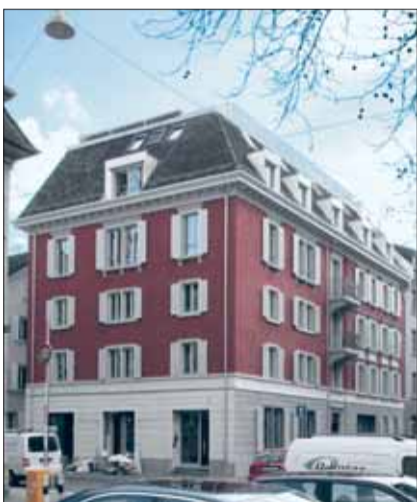
So gut wie neu oder sogar noch besser: Gespräch mit dem Architekten Karl Viridén über effiziente und wirtschaftliche Sanierungen. 6
