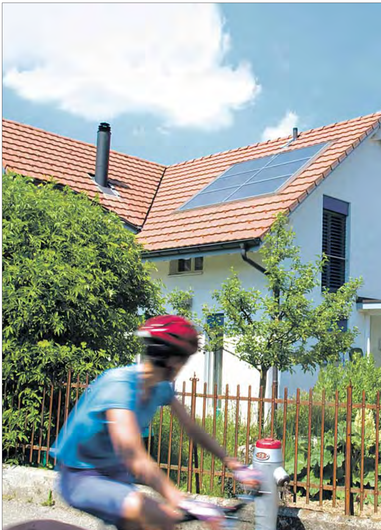
Quatre à six mètres carrés de collecteurs solaires sur le toit couvrent jusqu'à 70% de la consommation d'eau chaude d'une famille de quatre personnes. (Photos: Swissolar)
