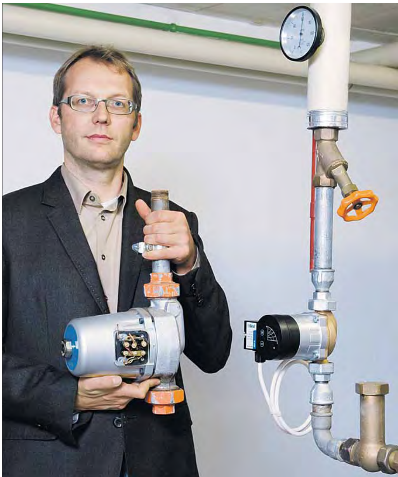
L'ingénieur Energho Daniel Zbinden, du bureau «Rückenwind» à Rüschlikon, tenant dans ses mains l'une des pompes tout juste remplacées dans l'immeuble GEWOBAG à Zurich-Albisrieden. La nouvelle pompe (à droite sur l'image) est maintenant correctement dimensionnée. (Photos: Christine Bärlocher)
