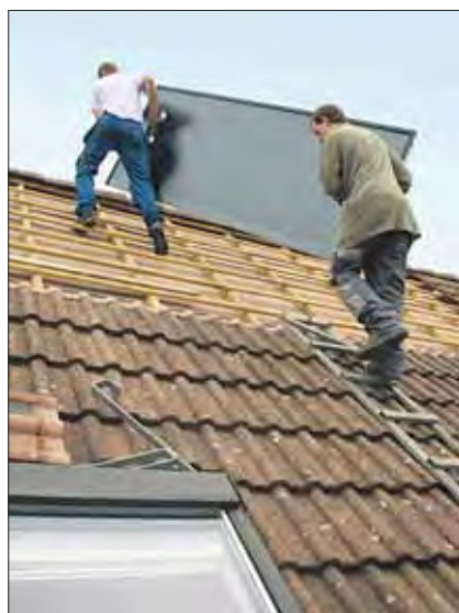
13h45: le collecteur est hissé sur le toit et mis en place précautionneusement.
