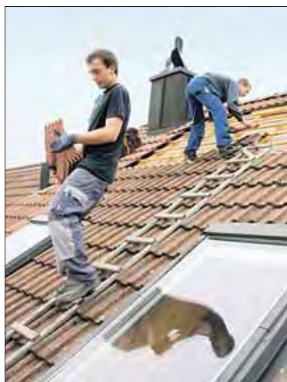
13h00: le toit est dégagé pour permettre le montage des lattes de fixation.
