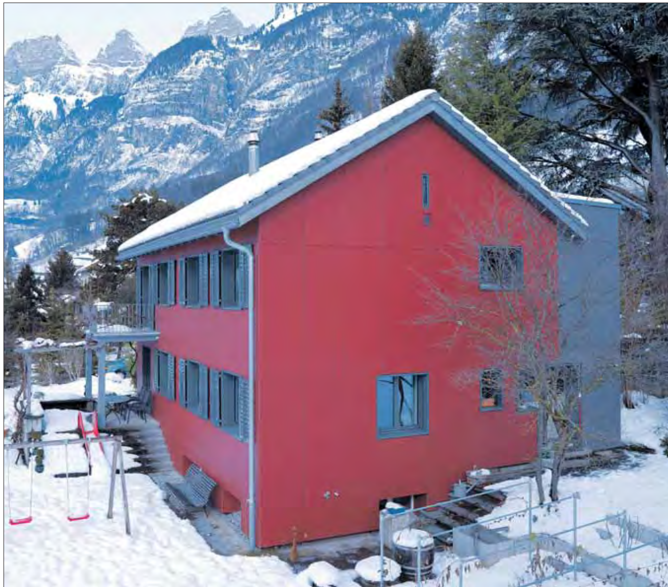
Cette maison individuelle, dûment isolée après modernisation, est maintenant chauffée par un poêle à pellets et des collecteurs solaires. (Photo: Regula Roost)
