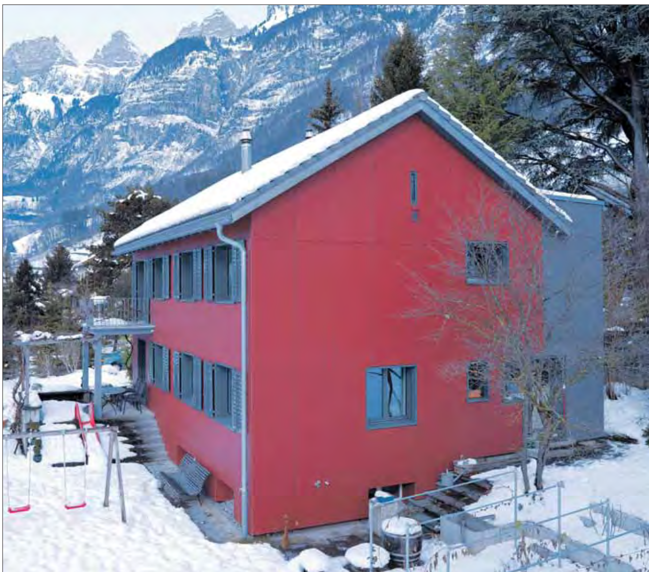
Das nach der Modernisierung gut gedämmte Einfamilienhaus wird nun mit einem Pelletsofen und Sonnenkollektoren beheizt. (Foto: Regula Roost)
