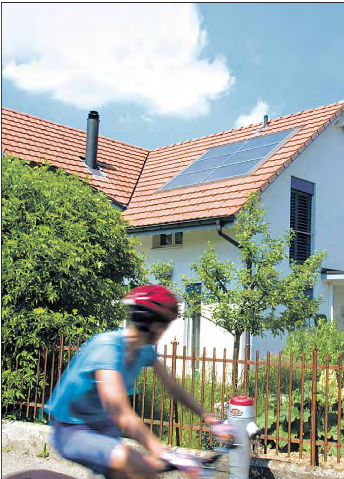
Vier bis sechs Quadratmeter Sonnenkollektoren auf dem Dach decken bis zu 70 Prozent des Warmwasserverbrauchs einer vierköpfigen Familie. (Fotos: Swissolar)
