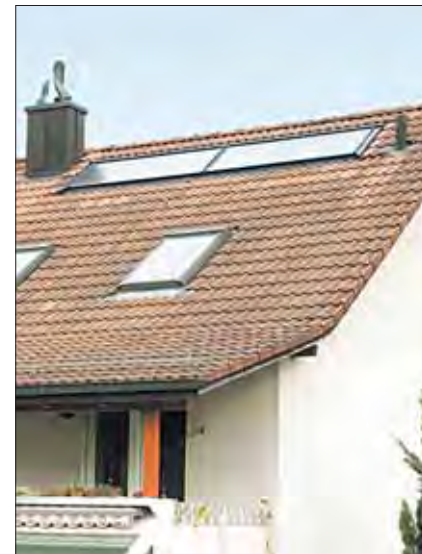
17.00 Uhr: Nach nur einem Tag ist die Solaranlage für Warmwasser samt dem Speicher montiert.
