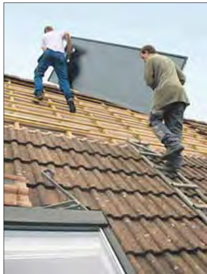
13.45 Uhr: Der Kollektor wird auf das Dach gehoben und vorsichtig aufgesetzt.
