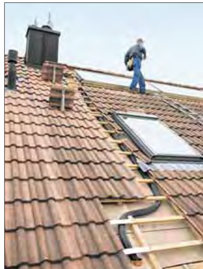
15.15 Uhr: Die Leitung wird fachmännisch verlegt.
