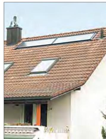
Ore 17:00: dopo un solo giorno l'impianto solare per l'acqua calda sanitaria è montato assieme all'accumulatore.
