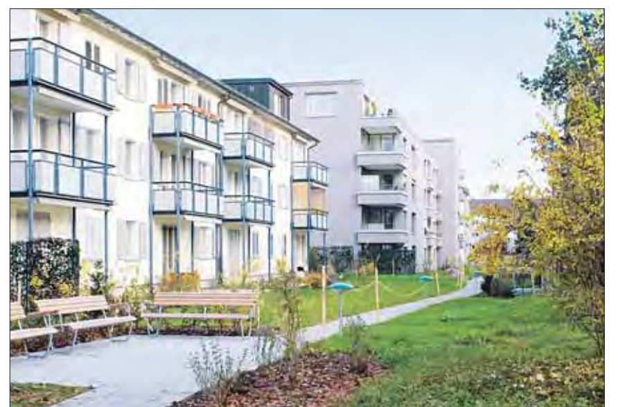
L'abonnement Energho a permis à la société GEWOBAG de réduire les coûts énergétiques de cet immeuble à Zurich-Albisrieden de 25% dès la première année – sans investissements proprement dits.
