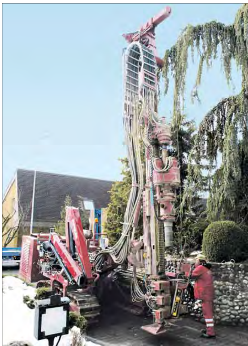
La tour de forage est dressée et positionnée exactement. La petite grue sur le côté servira ensuite à hisser les barres de forage et les tubes chemisés pour la mise en position correcte au-dessus du trou de forage.
