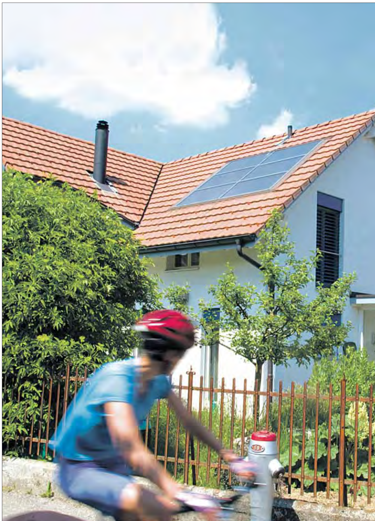
Quatre à six mètres carrés de collecteurs solaires sur le toit couvrent jusqu'à 70% de la consommation d'eau chaude d'une famille de quatre personnes. (Photos: Swissolar)
