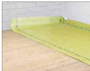
Per prima cosa si posa la barriera impermeabile all'aria sull'intera superficie del pavimento tendendola bene sopra i bordi, anche in corrispondenza delle travi di sostegno e della canna fumaria.
