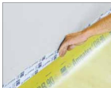
Poi si devono impermeabilizzare le giunzioni e i giunti perimetrali sigillandoli con un nastro adesivo adatto o con un adesivo per giunti perimetrali.
