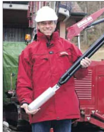
**Urs Burkhard, capo dell'impresa edile Bürgler, mostra la punta di una sonda geotermica. Nel tubo ad U nero circola un liquido che in profondità viene riscaldato dalla terra.** Foto: Regula Roost
