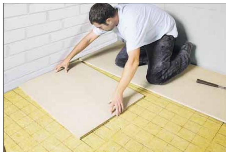
**3** Anche il pavimento di pannelli truciolari va posato in opera avendo cura di sfalsare i giunti in modo da evitare la formazione di giunti incrociati.
