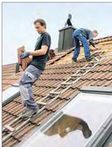
Ore 13:00: il tetto viene sopperchiato per montare i listelli di fissaggio.
