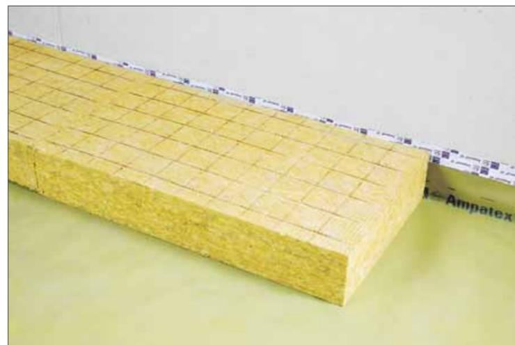
**1** Posare in opera i pannelli isolanti sull'intera superficie del pavimento.
