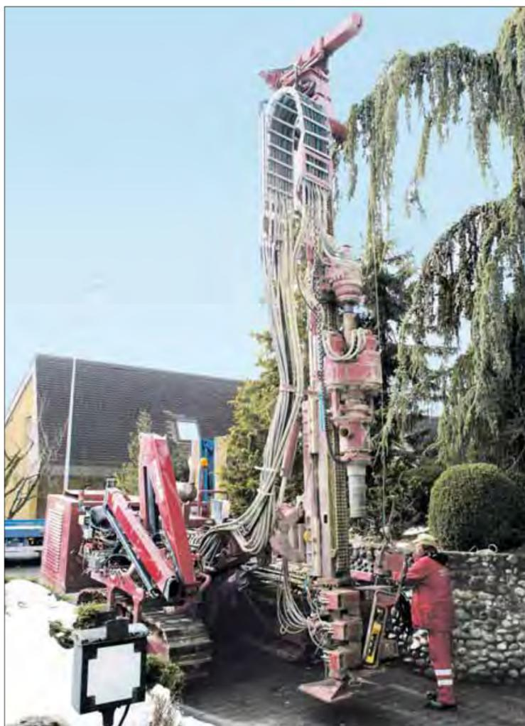
**La torre di perforazione viene eretta e posizionata con precisione. Con la piccola gru a lato saranno sollevate le aste di perforazione e i manicotti per essere collocati nella posizione giusta sopra il foro di perforazione.**
