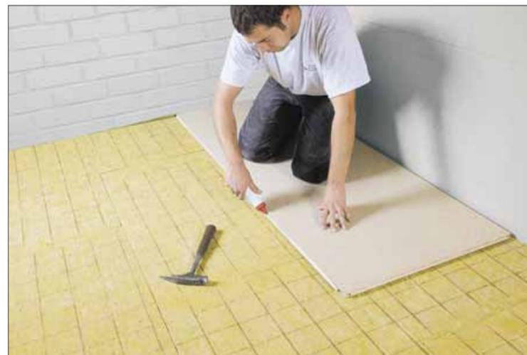
**2** Ora si posa in opera il pavimento di pannelli truciolari. Unire con colla a freddo per legno le giunzioni a maschio e femmina. Il pannello truciolare «galleggia» sul pannello isolante e non è incollato ad esso.
