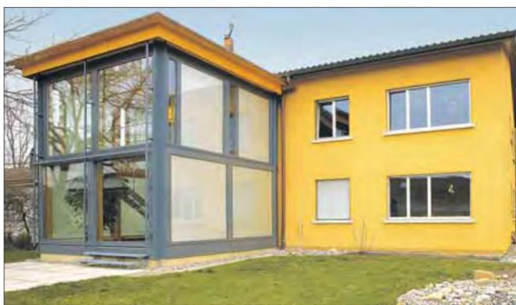
L'annesso a due piani è stato realizzato con elementi prefabbricati in una sola settimana. Al piano superiore si trova la camera da letto dei genitori. Quelle dei figli si trovano nella parte vecchia della casa che, ad eccezione dei bagni, è rimasta praticamente com'era.
