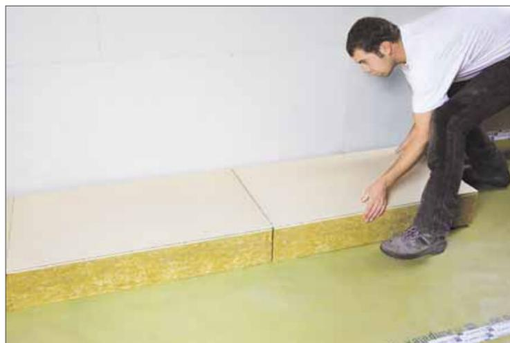
**1** Collocare il primo elemento per pavimenti di soffitte.
