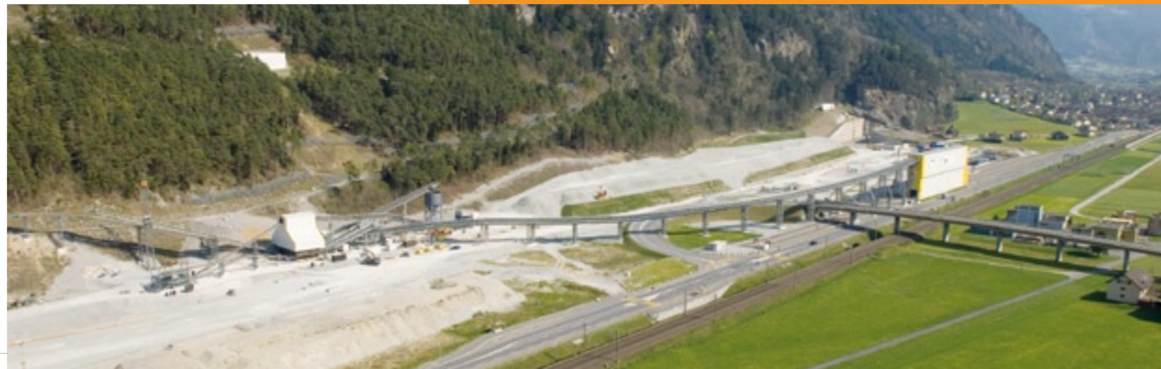
Baustelle der Neat in Erstfeld
