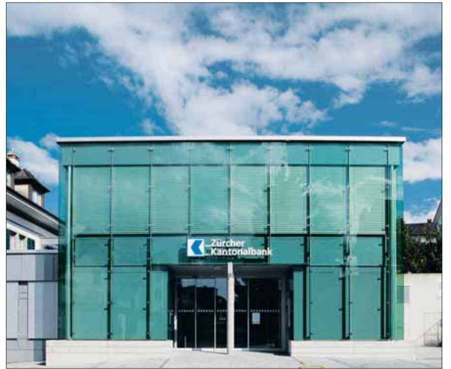
Zürcher Kantonalbank in Rüti: Die von der Blaser Metallbau AG realisierte Doppelhaut-Fassade erfüllt alle Sicherheitsanforderungen einer Bank.
