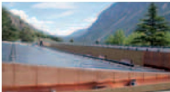
Figure 11 : La toiture solaire du centre sportif alimente le complexe en eau chaude sanitaire et chauffe en partie les bassins. (photo : Energie Solaire SA)
