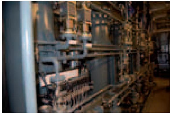
Figur 6: Die vier CO<sub>2</sub>-Adsorber der Faulgasaufbereitungsanlage bei der Ara Luzern.
