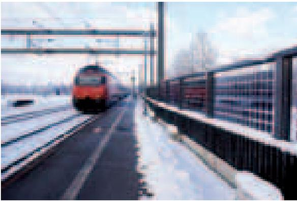
Figur 7: Bifaciale Photovoltaik-Lärmschutzanlage. (Bildquelle: TNC)
