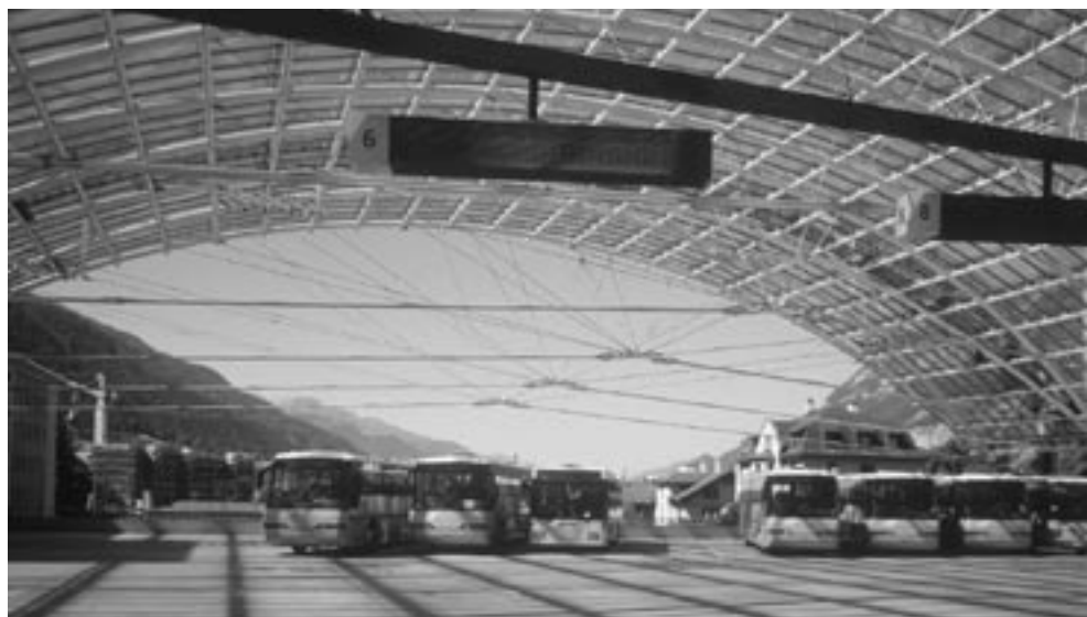
Agglomerationsverkehr: vom Stiefkind zum Förderobjekt
