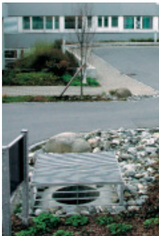
Des murets et des puits collecteurs ont été construits pour que l'hôpital ne connaisse pas une nouvelle inondation.
