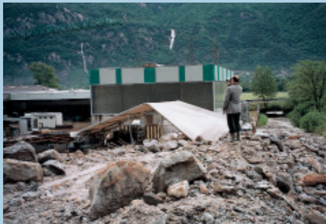
Evacuation des rochers accumulés sur le terrain de l'entreprise Genazzi & Artioli.
