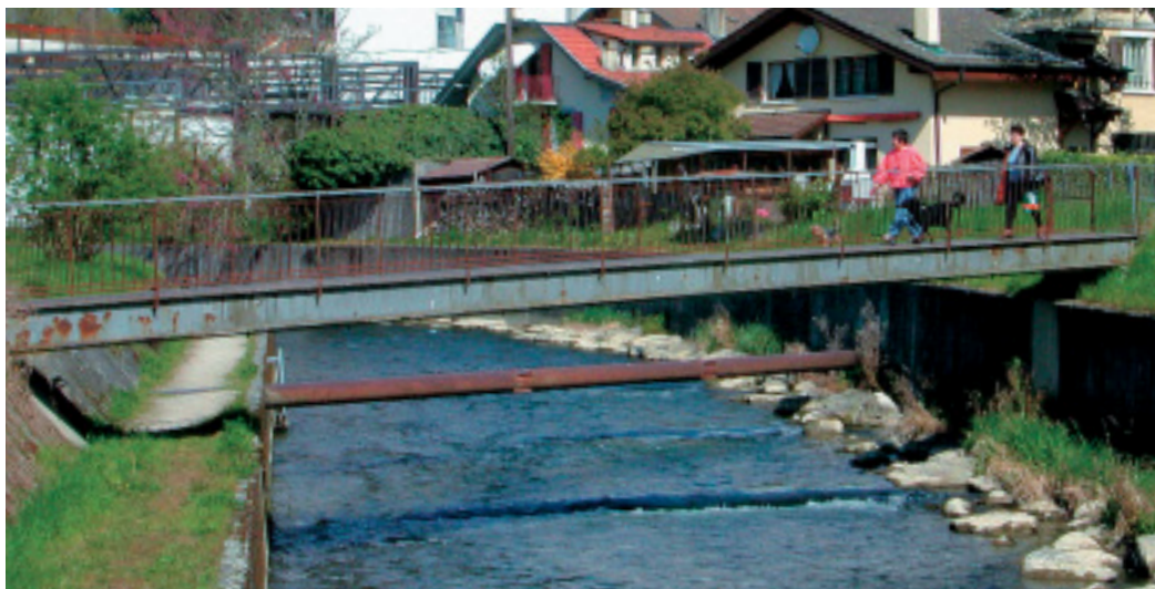
Le cours inférieur de la Versoix en avril 2002. La rivière est canalisée entre des murs de béton, une canalisation des eaux usées la traverse près de la passerelle – une zone à risque potentielle lors de crues.
