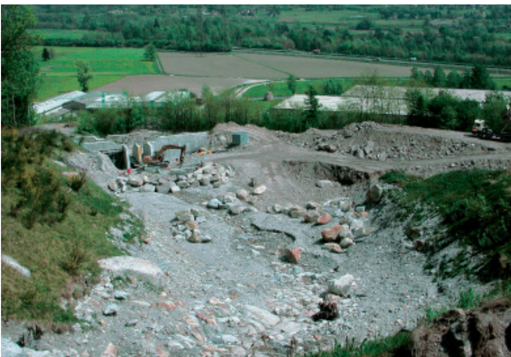
Les bassins de rétention actuels verront leurs capacités doubler.
