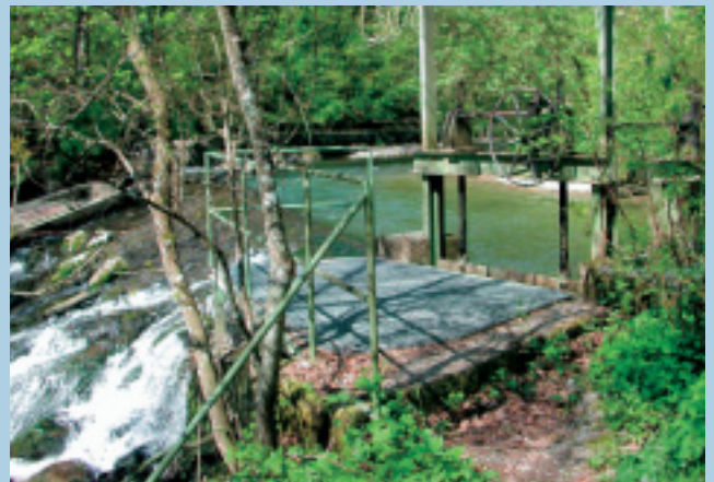
Ici le Canal des Usiniers se sépare de la Versoix. Le niveau d'eau dans le canal est régularisé par les commerçants avec des écluses.
