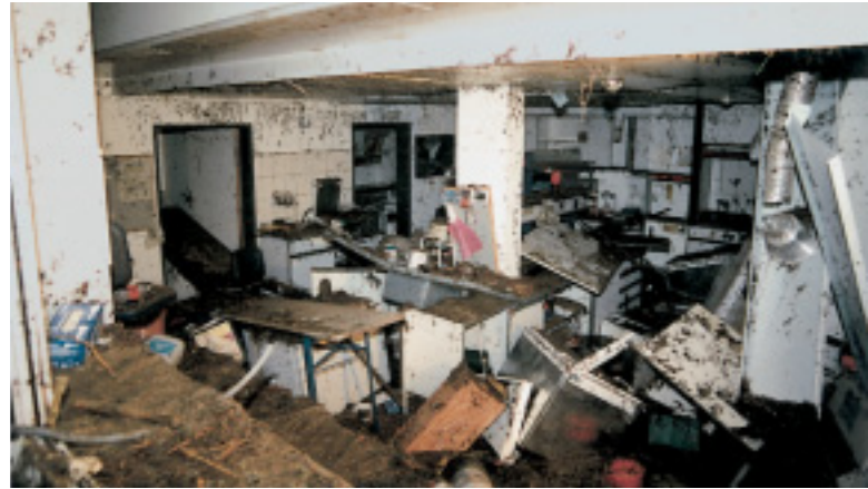
Le laboratoire de l'hôpital – état de la destruction.
