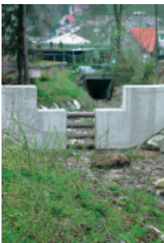
Les matériaux – arbres et grosses pierres – charriés par le Werdbach sont arrêtés par deux grandes grilles placées à l'embouchure du dalot. Selon les calculs de spécialistes, l'eau devrait continuer à s'écouler normalement, même lorsque les pieux verticaux et horizontaux seront remplis de charriage.
