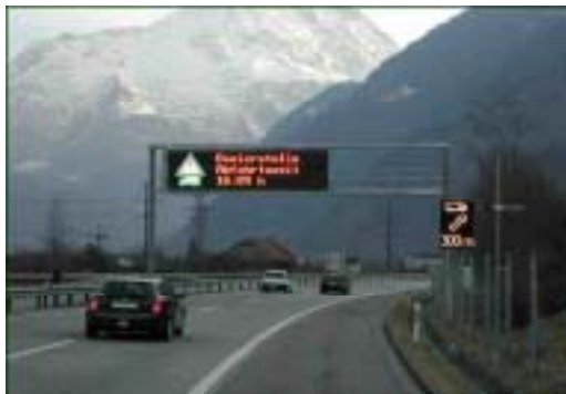
Abb. 4: Wechseltextanzeige mit Abfahrtszeit Dosierstelle Amsteg
