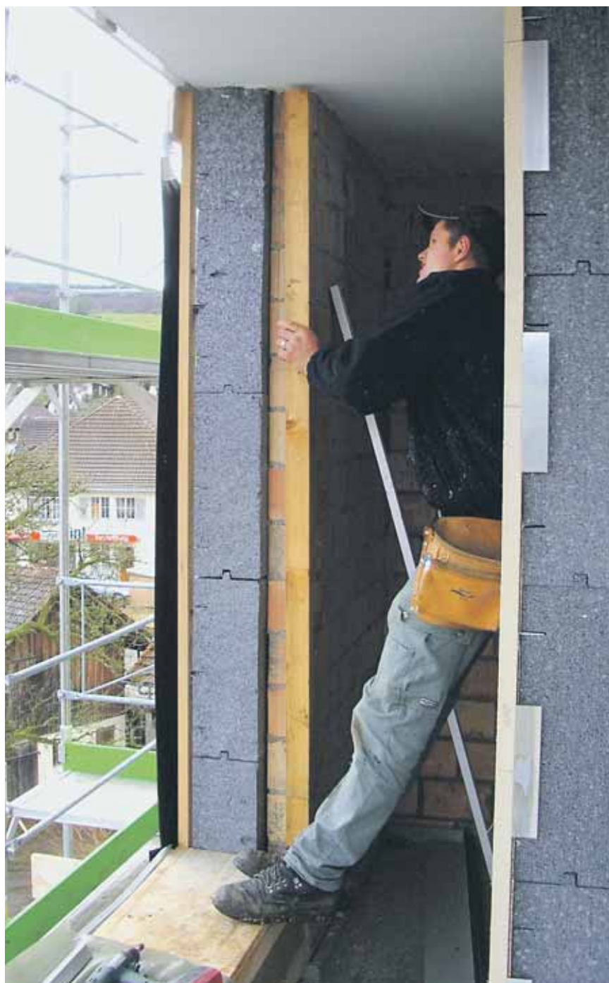
Un polybâtitisseur de la spécialisation construction de façades isole le mur extérieur avec des plaques EPS de 18 cm d'épaisseur.
