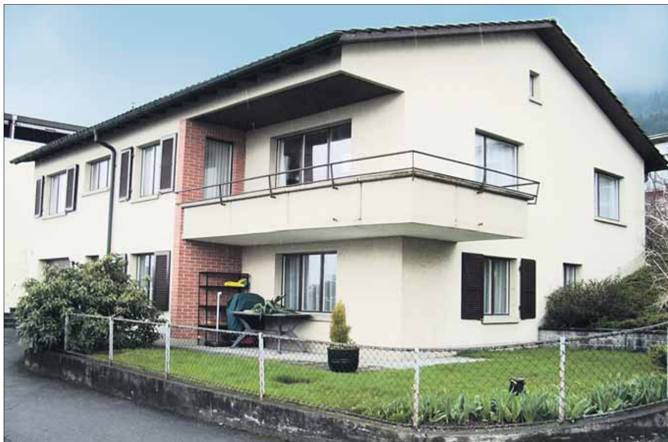
L'ancienne maison de 1962 avait besoin d'être rénovée et était beaucoup trop exigüe.
