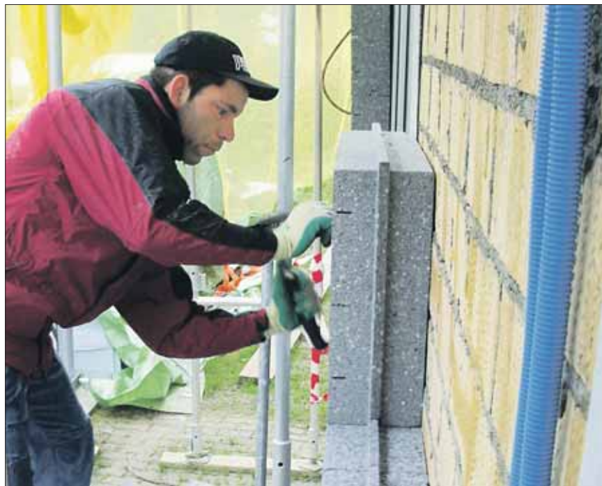
Un polybâtitisseur de la spécialisation construction de façades isole le mur extérieur avec des plaques EPS de 18 cm d'épaisseur.
