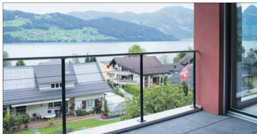
Dove prima c'era la soffitta, adesso c'è una grande terrazza coperta e degli splendidi locali di soggiorno.
