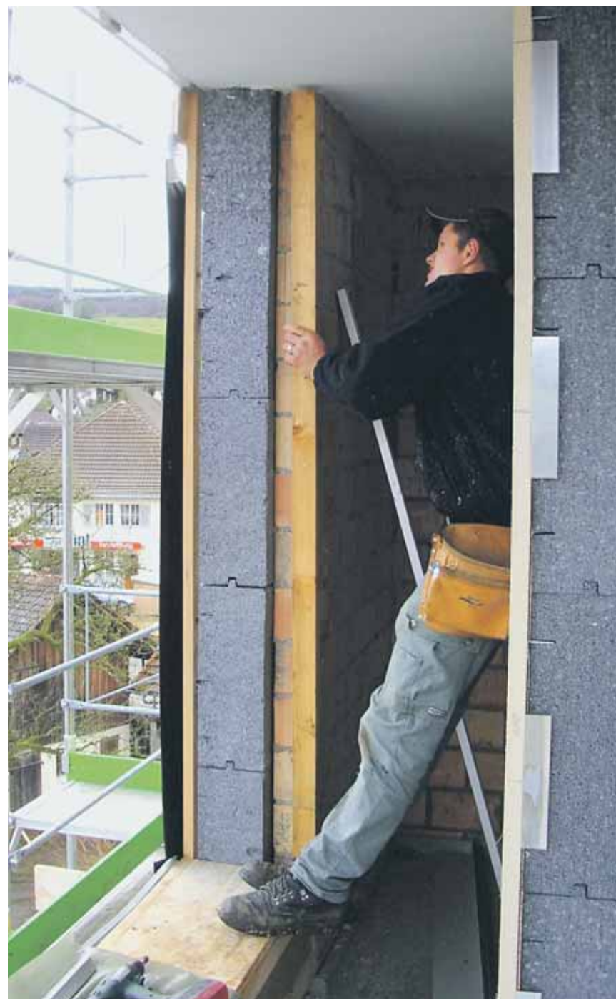
I policostruttori specializzati in facciate isolano la parete esterna con pannelli EPS di 18 cm di spessore.
