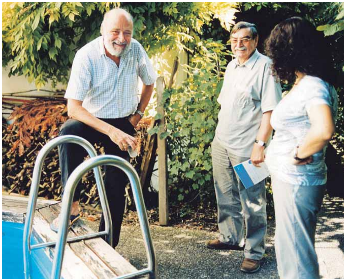
Urs Leuenberger riscalda in modo energeticamente efficiente anche l'acqua della piscina con i collettori solari. (Fotos: Arnold Kohler)
