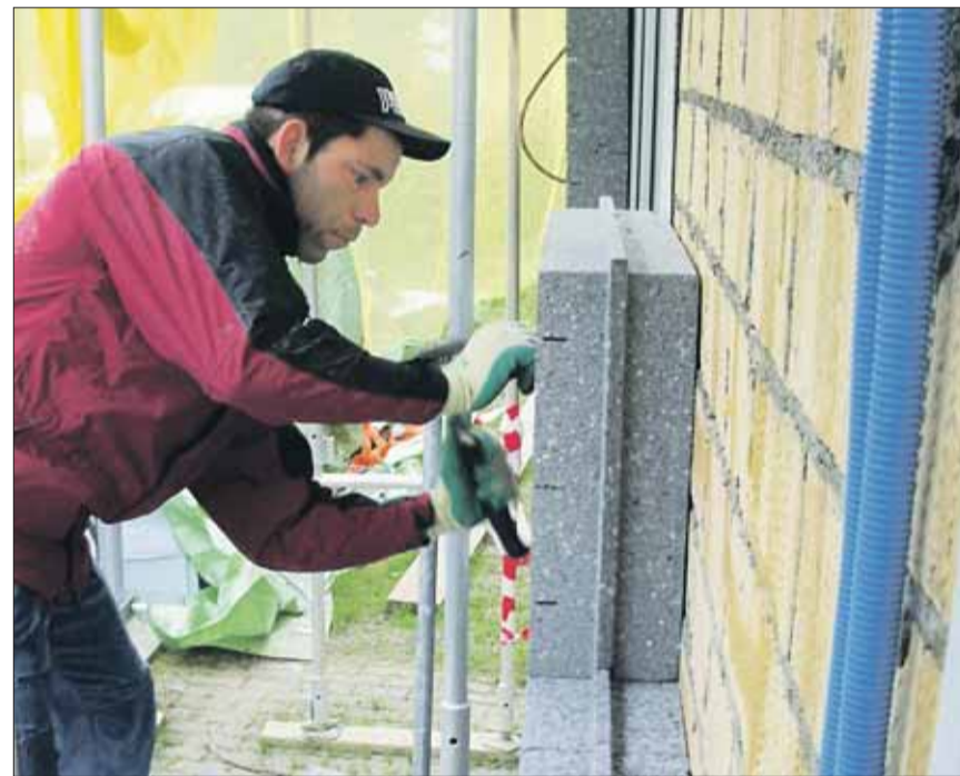
I policostruttori specializzati in facciate isolano la parete esterna con pannelli EPS di 18 cm di spessore.
