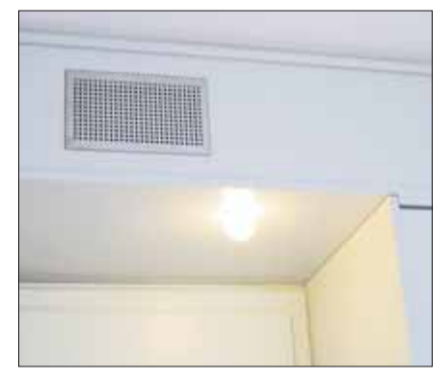
Qui sopra il telaio delle porte sono state incassate le tubature per il ricambio d'aria.
