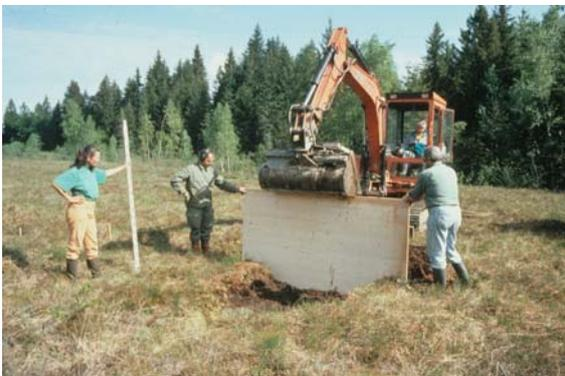
L'affondamento di tavole di legno nel terreno costituisce un metodo efficace per ostruire i fossati di drenaggio.
