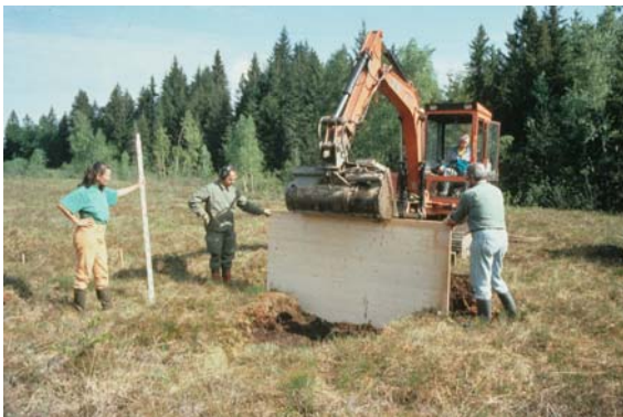
Das Einrammen von Holzbrettern ist eine effiziente Methode zur Verschliessung von Drainagegräben.
